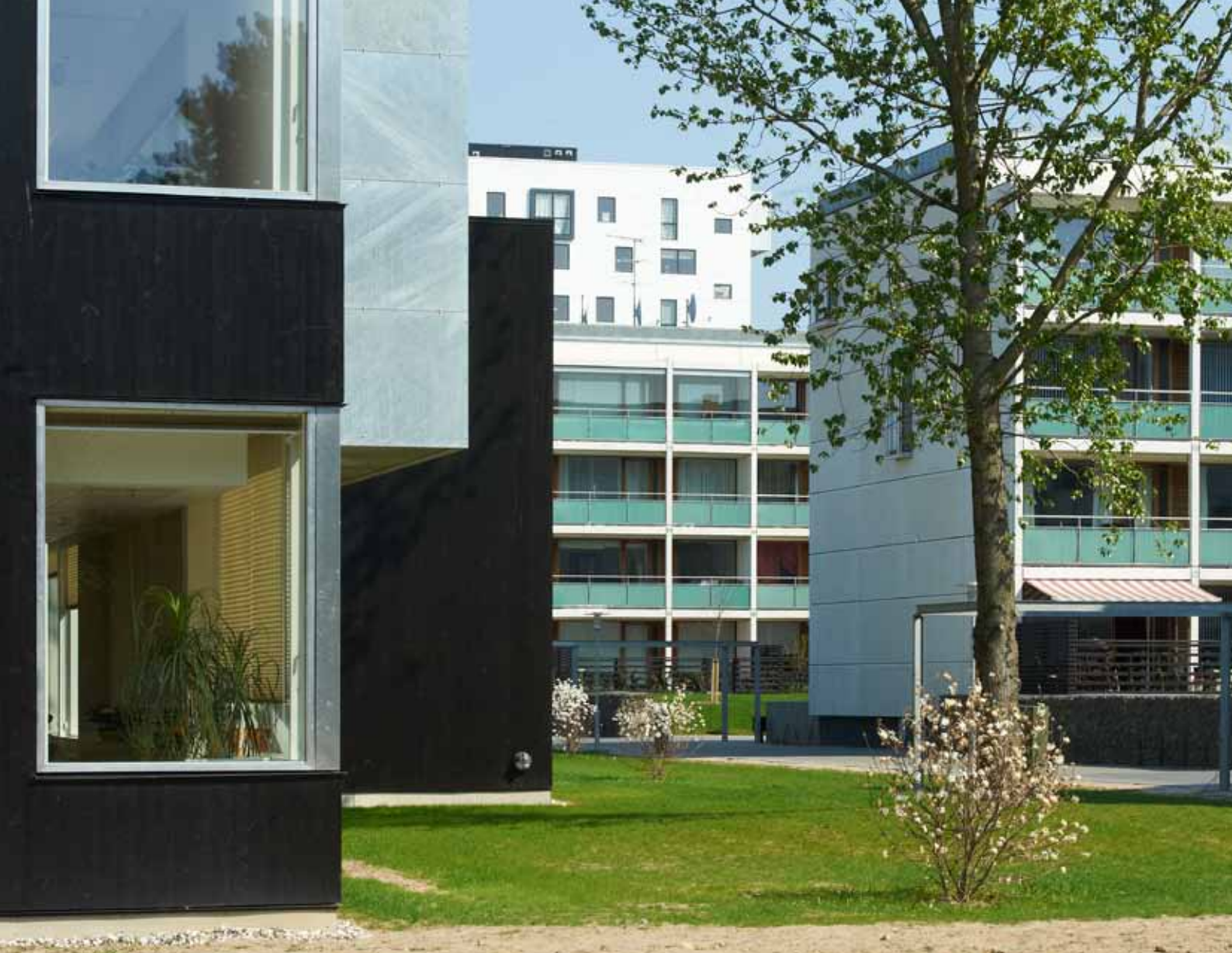
Gyldenrisparken, København S • Renovering og nye plejeboliger • Bæredygtigt byggeri • Boligselskabet Lejerbo
