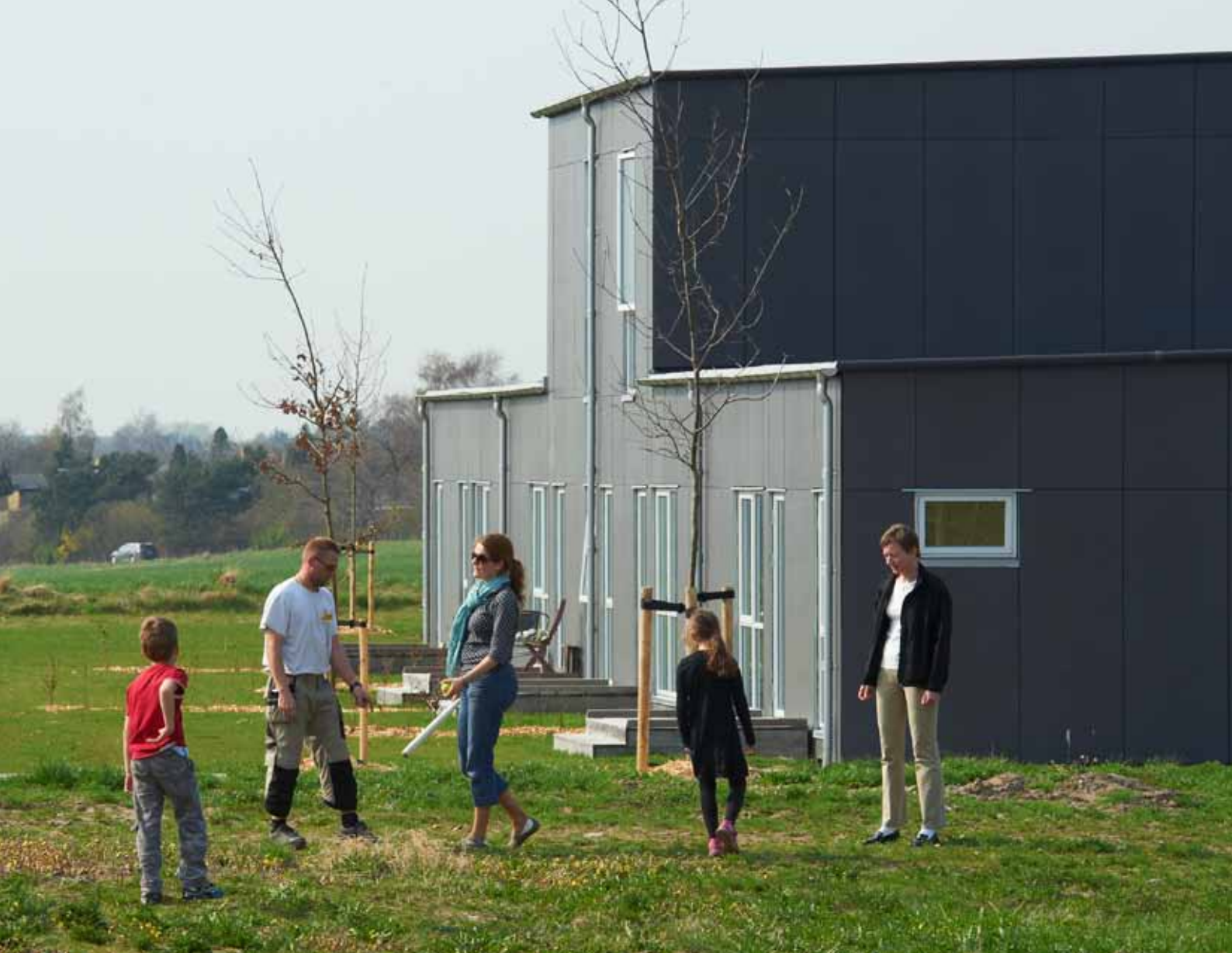
Stenløse Syd • Lavenergiboliger • Stenløse-Ølstykke Boligforening
