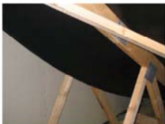
Manglende afskæring af undertagsbane (flap)
